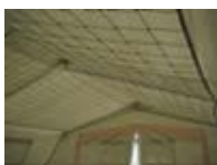
全面に張られた 天井ネット
